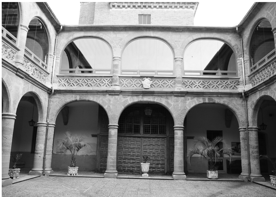
Lám. 3. Estado del patio en el año 2017 una vez terminada la obra
