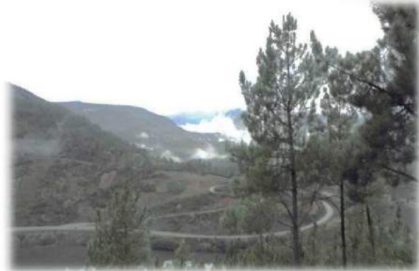
Vistas sobre le río Sil, la N-120 y la vía férrea
