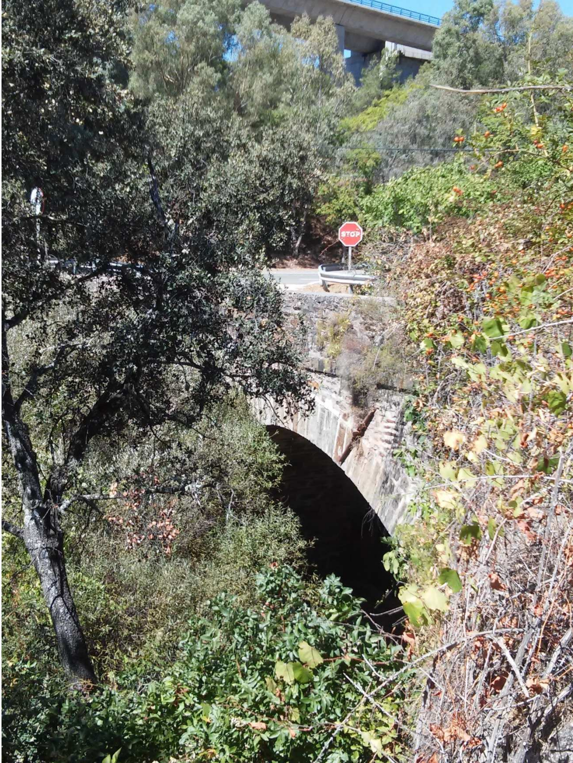
Vista del puente, aguas arriba. Al fondo, el viaducto de la autovía. Foto M.Roll
