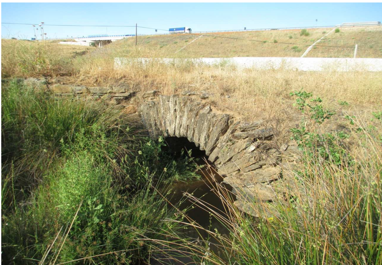
Alcantarilla de Castro; al fondo la autovía dirección sur. Foto M. Roll
