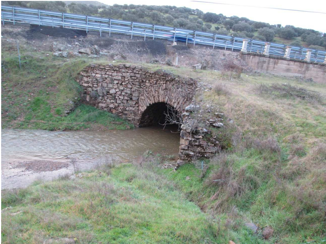
Puente menor sobre el arroyo Ramacominos. Foto M. Roll
