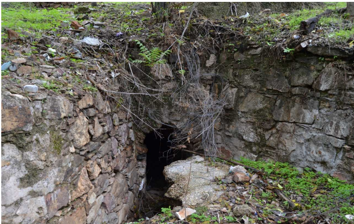
Alcantarilla del Barranco de la Niebla. Foto M.Roll
