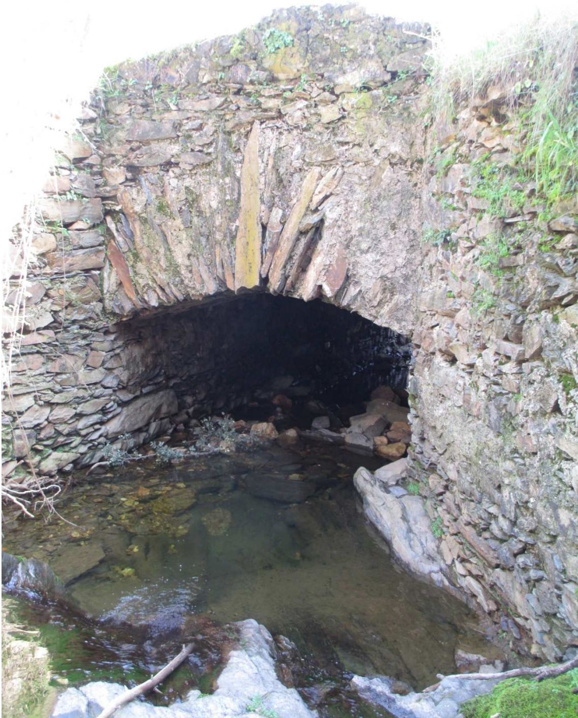
Puente-alcantarilla de Valdeazores. Foto M.Roll
