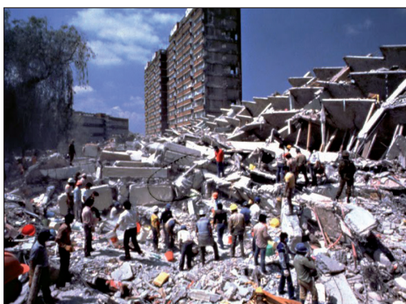
b) Colapso del Edificio C-4 Juárez
