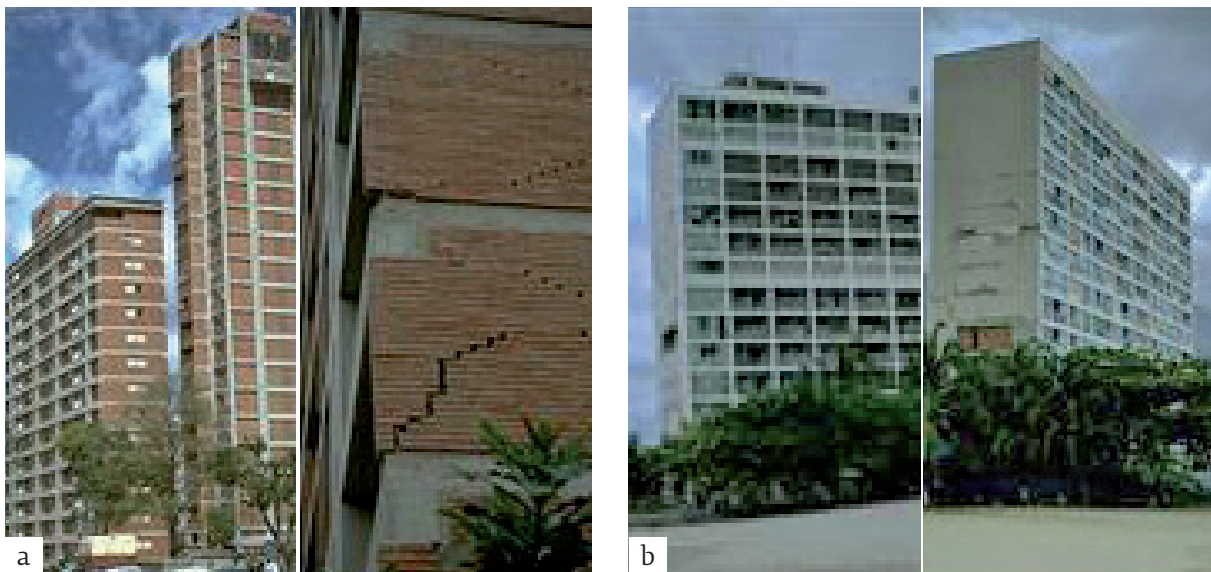
Figura 1. Edificios poco redundantes en la dirección corta que presentaron daño estructural durante el sismo de Caracas (fotos de la colección de Karl Steinbrugge, Web-Berkeley 2010).
