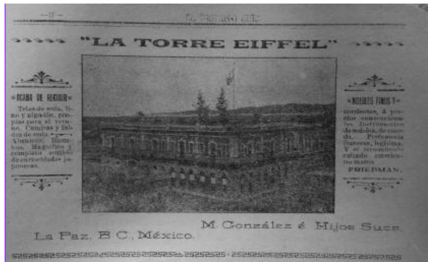
Fuente: El Distrito Sur , 30 de abril de 1907, AHPLM
