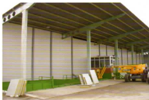
IMAGEN No. 5 APANTALLAMIENTO LATERAL DEL PATIO DESTINADO A ATENUAR EL RUIDO DE TRÁFICO RODADO
