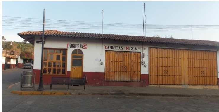
Figura 20. Edificación con muestra de puertas prototipo y de puertas y ventanas metálicas color madera.
