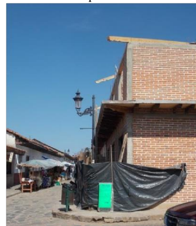
Figura 19. Construcción por la calle peatonal Hidalgo en el año 2013, anteriormente vivienda vernácula. Fuente: Foto tomada por la autora.
