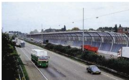
Figura 9. Vista de la barrera voladiza, no altera el paisaje y crea una sensación de modernidad.
