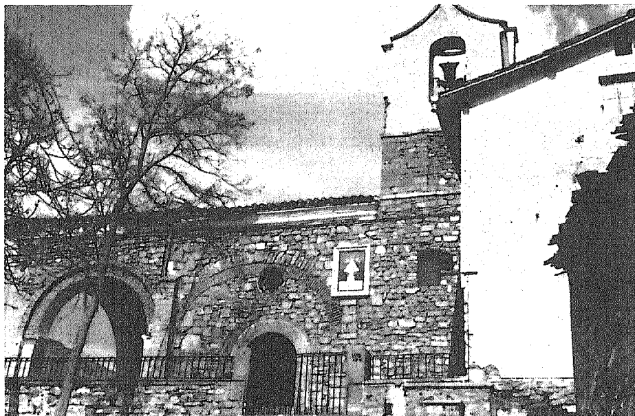
Ermita de Nuestra Señora del Cortijo. Vista del muro sur
