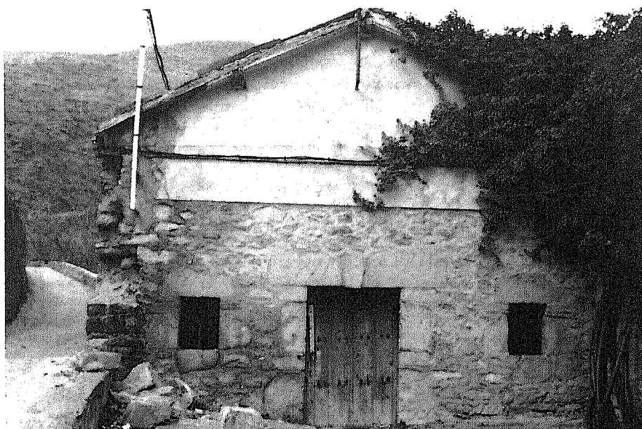
Ermita de San Blas. Vista del ingreso
