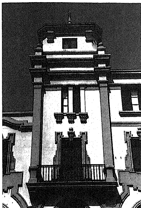
Fig. 10. Casa de Correos y Telégrafos, detalle.
