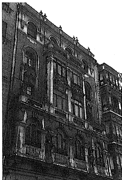
Fig. 18. Edificio de viviendas en Portales 21. Agapito del Valle, 1930.
