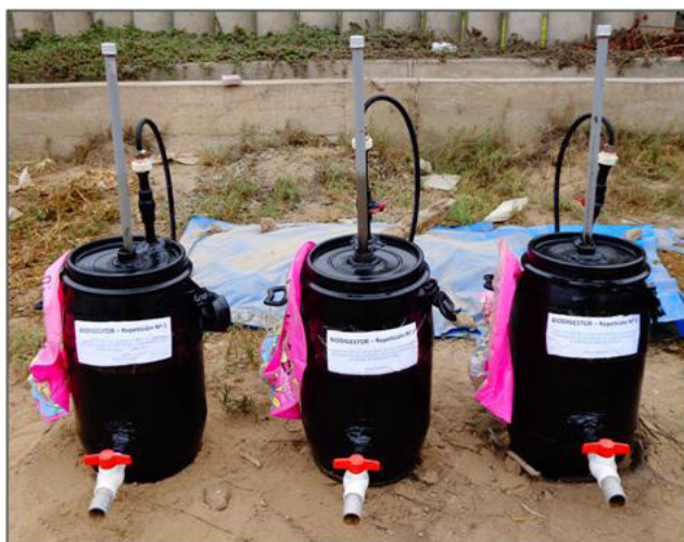
Figura 3. Instalación de tres biodigestores para el Tratamiento 1.
