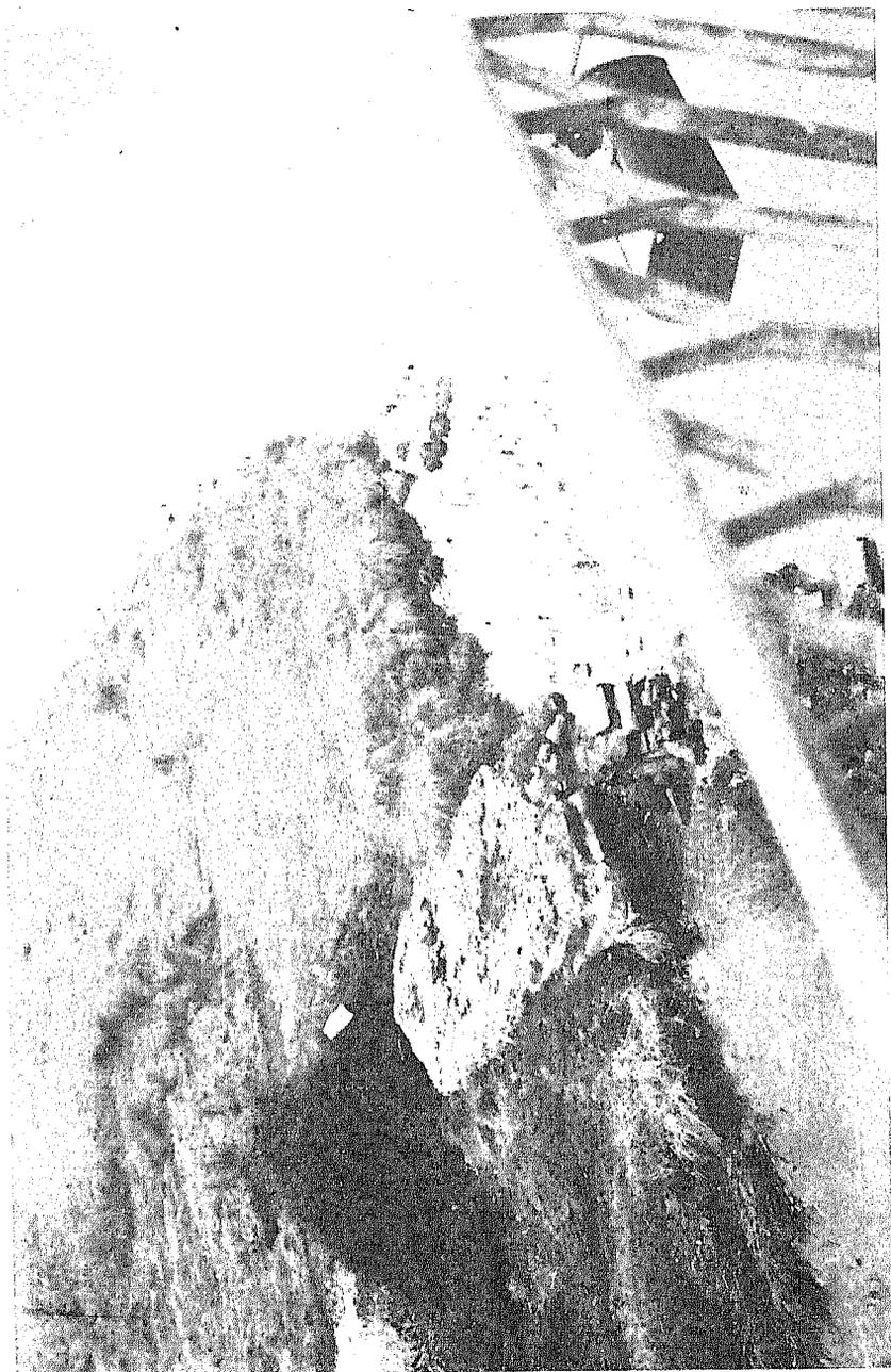
Lám. 1.— Estado actual del resto de estribo de pilar visto desde el Puente Piedra. Se observan las dos hileras de sillares en la parte posterior y lateral izquierda de la pila enclavada en El Sotillo.
