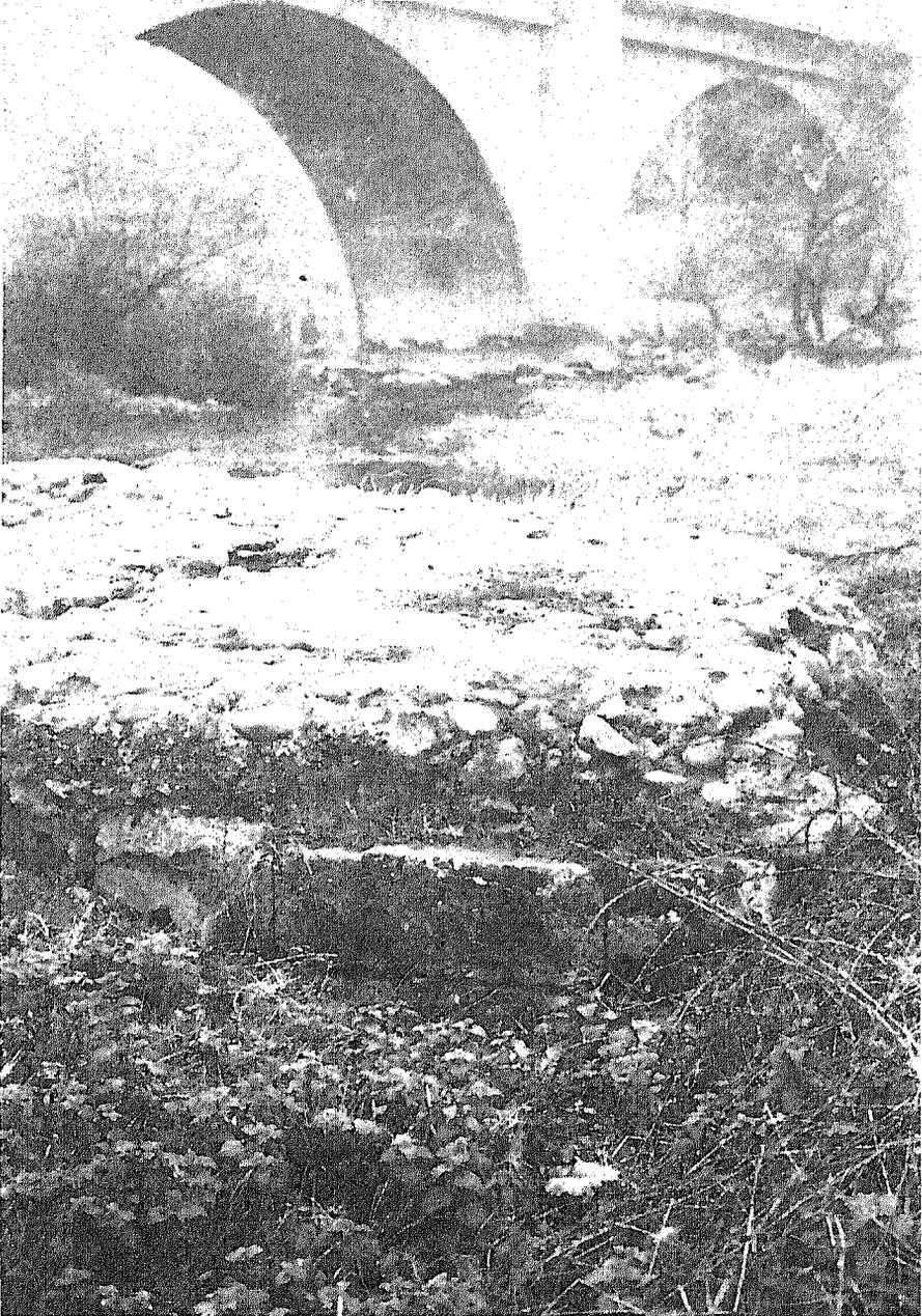
*Lám. 2.— Hileras de sillares del tajamar de la pila, con material de relleno en su interior compuesto de cantos rodados. Al fondo el Puente Piedra de Logroño sobre el Ebro.*
