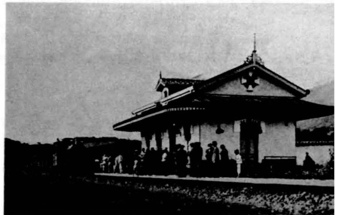
5. Estación Bosque de la Independencia, cerca de Medellín. Ferrocarril de Antioquia. Ejemplo de estación pequeña.
