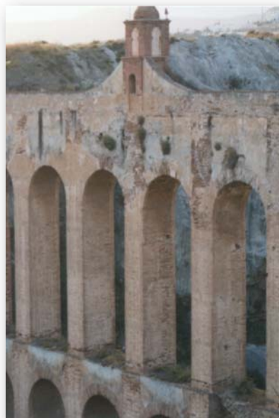
Arcadas del Puente del Águila
