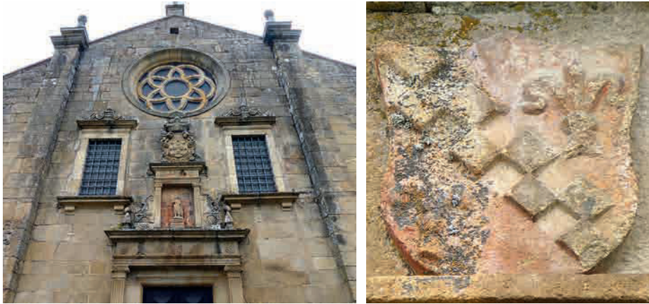
Monasterio de Tarouca. Fig. 10a (izq.): fachada de la iglesia reformada en el siglo XVII. Fig. 10b (der.): escudo sobre el dintel de la puerta de la iglesia.
