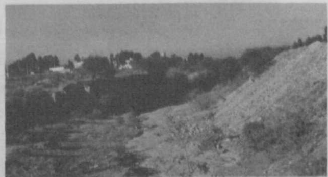
Figura 9 y 10. Secciones del arroyo azolvadas con desechos domésticos y escombros..
