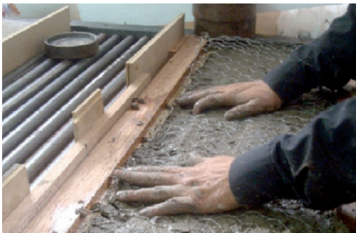
Imagen 13. Colocación de malla
