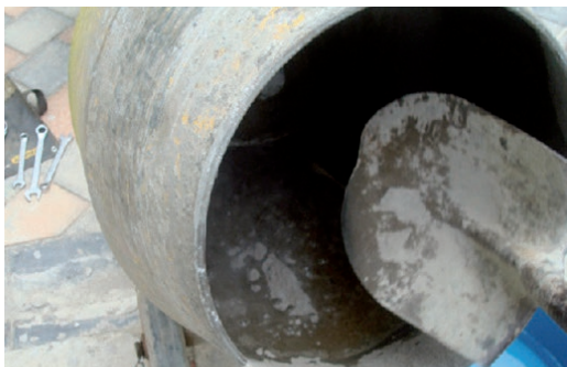
Imagen 7. Agregar el cemento
