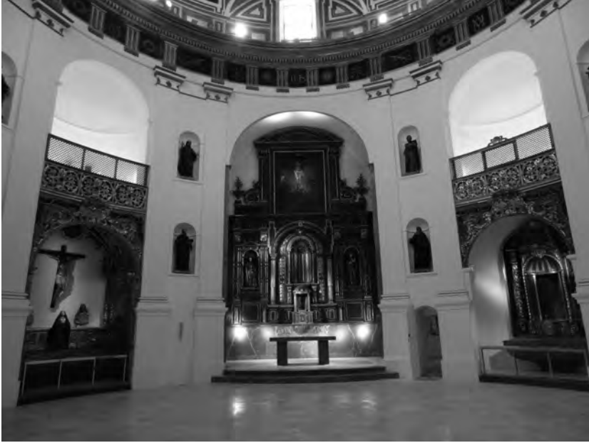
17. Interior de la iglesia una vez finalizada su restauración. AMP. IAPH.
