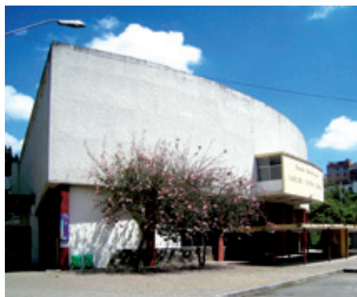
Estado anterior a la readecuación
