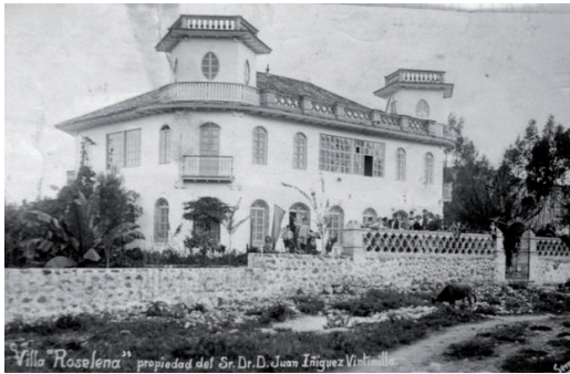
Figura 2. Fotografía de la Villa Rosa Elena antes de su demolición.
