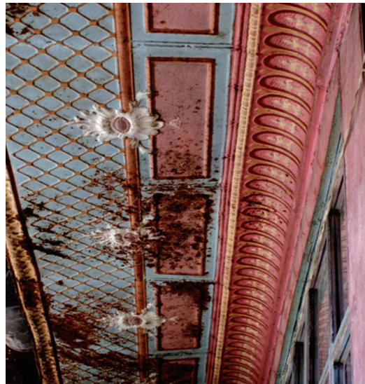
Imagen 3. Cielo raso de latón de la Casa de las Palomas. Fuente: Propia.
