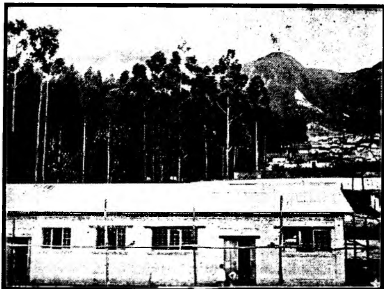
El Pabellón de Cirugía, en construcción
