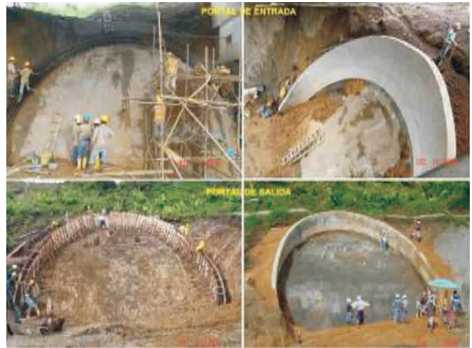
Figura 10. Aspecto de las vigas preanillo durante la construcción (izquierda) y luego de terminadas.
