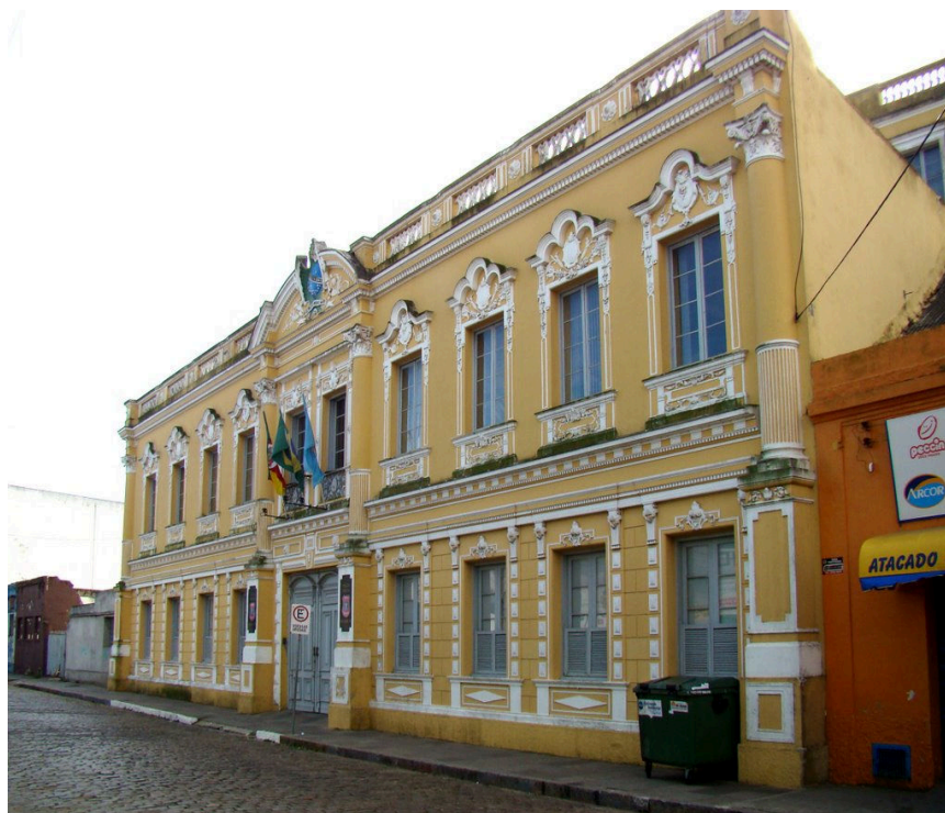
Figura 1 – Edifício da Delegacia da Polícia Federal do município de Rio Grande, RS Fonte: https://ssl.panoramio.com/
