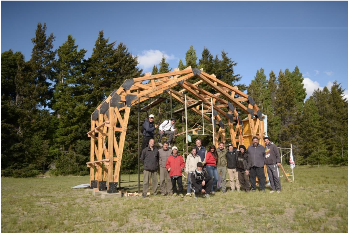
Imagen 5. Montaje del módulo estructural piloto. Fuente: Equipo Co-construcción de Conocimientos, 2013.
