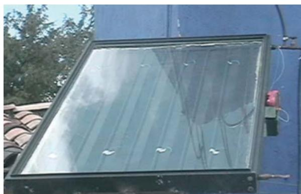
Figura 5. Colector solar plano fabricado e instalado en los techos de las casas.
