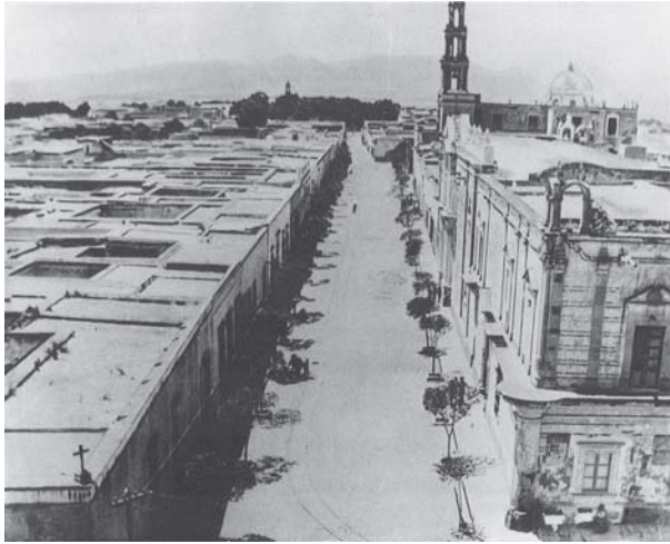
Figura 5. En el paramento sur de la calle Carranza se observa una altura uniforme. Fondo CIRA: Pag. 31, Fot. 120, AHEA.
