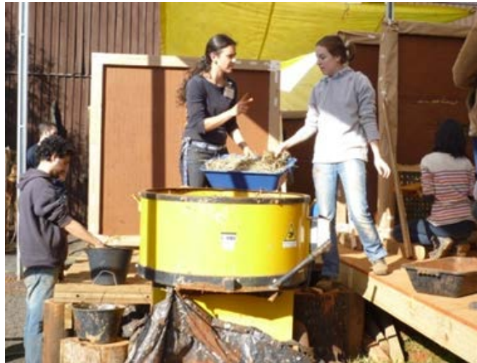
Figura 3: Ajuste da terra da primeira camada. Credito: Ceneviva, 2013
