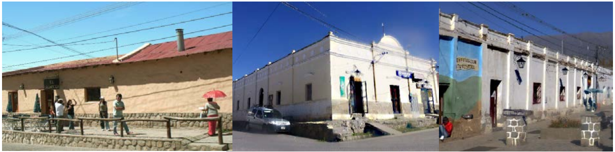
Figura 2. Fachadas del casco fundacional
