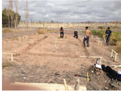
Figura 2. Replanteo de la obra
