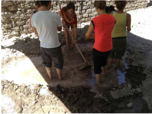
Figura 1. Elaboración de adobes
