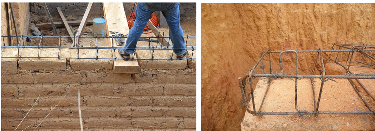
Figura 7. Armado con grapas de acero amarradas a cada 60 cm para anclar la estructura de madera a los muros
