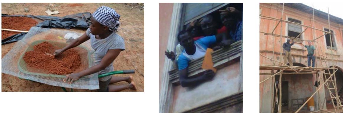
Figura 6: Seleção e beneficiamento da terra; Execução de moldes – carrinhos deslizantes – para execução das cimalkas e molduras; Construção e montagem dos andaimes (Créditos: Pedro Paulo Vitor, 2012)
