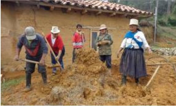
Figura 12. Proceso de elaboración del revoque
