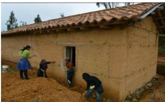
Figura 10. Excavación de zanjas perimetrales para desalojo de aguas lluvias
