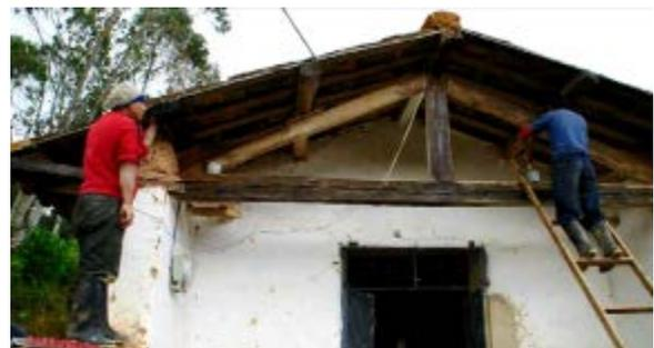
Figura 21. Aplicación de aceite de linaza a madera existente
