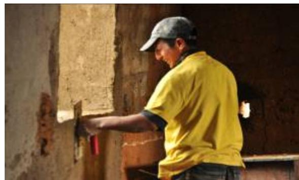
Figura 17. Acabado de filos de ventanas
