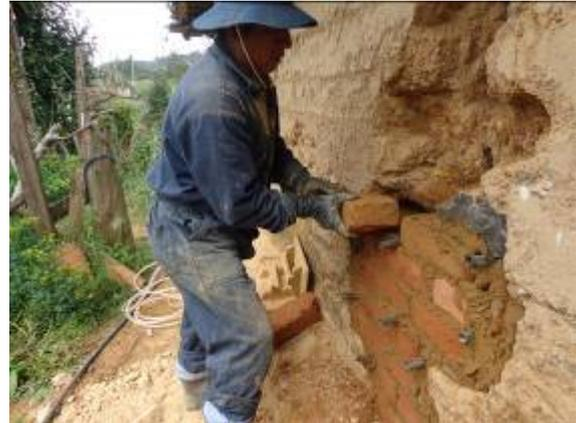
Figura 9. Consolidaciones, cocidos y descocidos de muros
