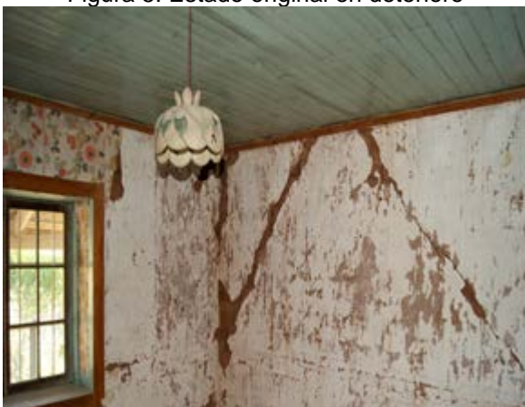
Figura 7. Grietas en muro dormitorio
