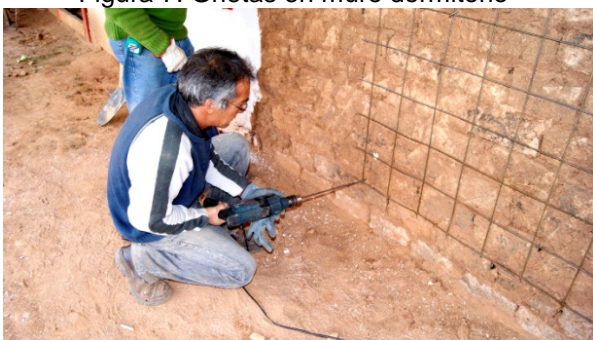
Figura 9. Colocación malla Acma en muro
