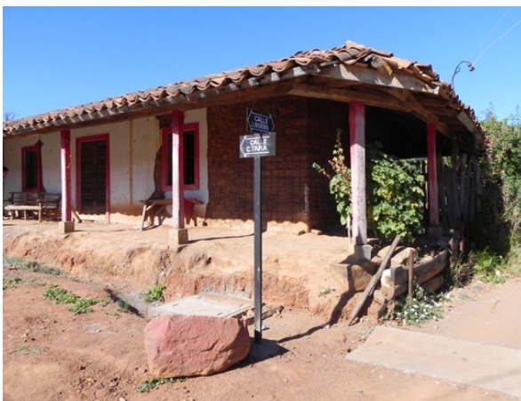
Figura 5. Estado original en deterioro
