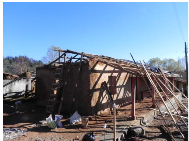
Figura 6. Desarme de vivienda
