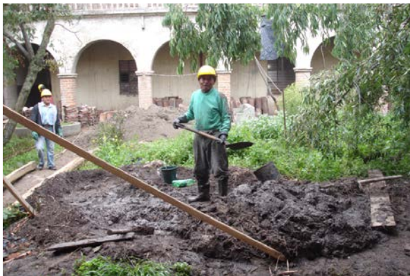
Figura 1. Batido manual de un mortero de tierra
