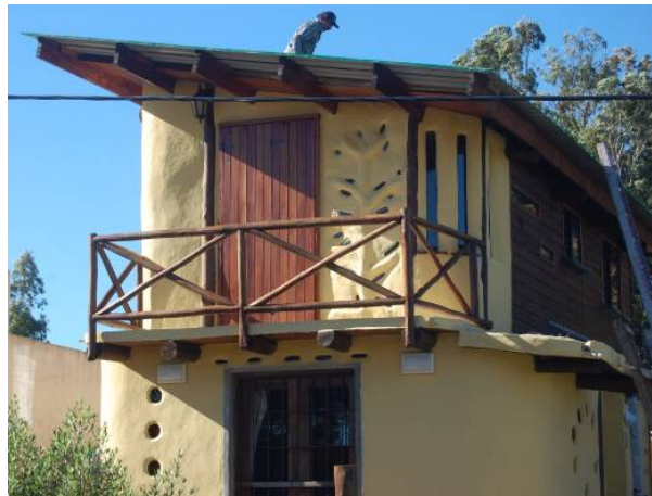
Figura 1. Revoque de cal sobre la pared de tierra en balneario Playa Verde, Maldonado, Uruguay
