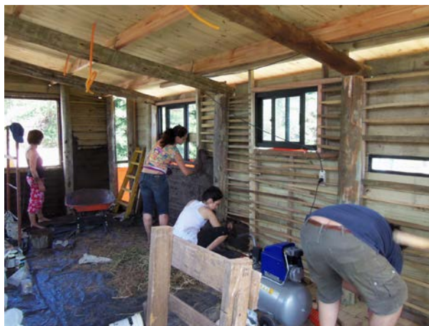
Figura 3. Jornada de embarrado de paneles de fajina
