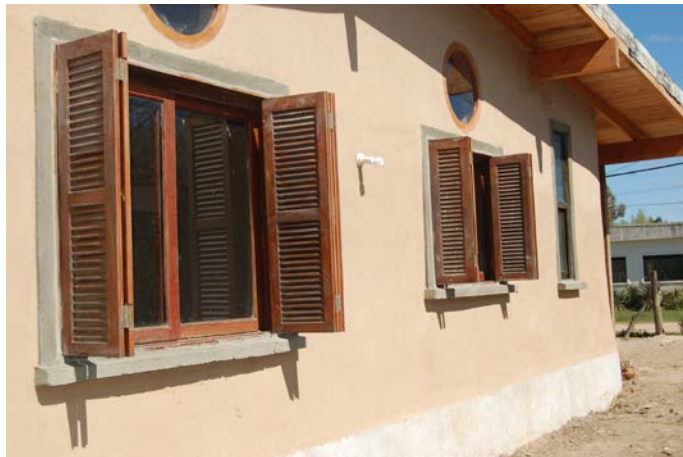
Figura 9. Cob en pared exterior al norte
