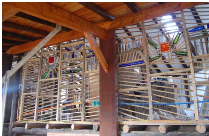
Figura 10. Paneles de fajina al interior, entramado simple
