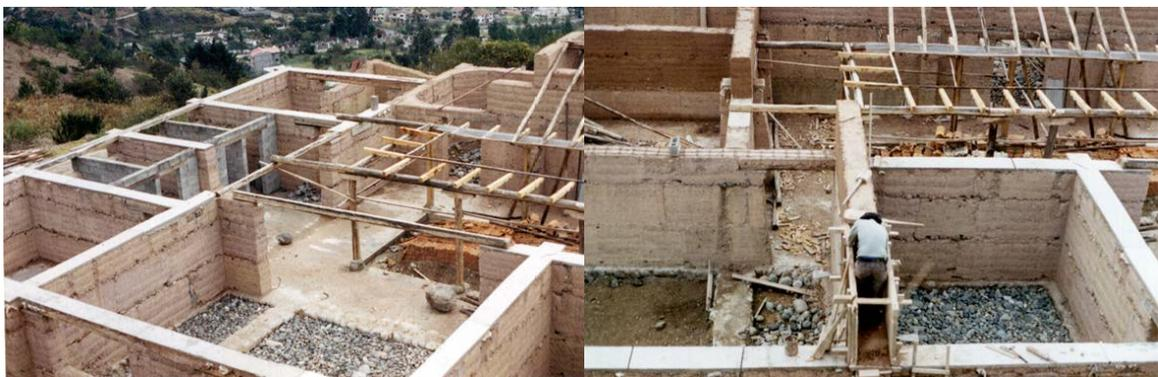
Figura 4. Muros de tapial en construcción
