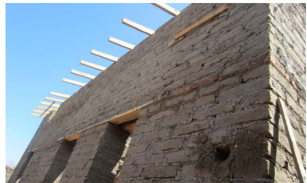
Figuras 5 y 6. Diseñada en 2 plantas, con 40 cm de espesor y múltiples vanos. Delgadas vigas dintel y anillo intermedio.
