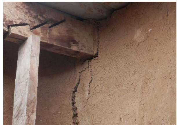
Figuras 3 y 4. Falta de dinteles. Falla en el empalme de la madera y grietas en los apoyos del larguero
