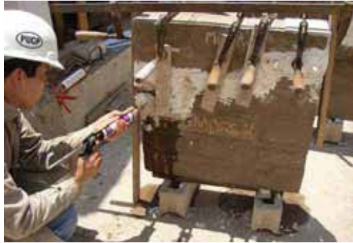
Figura 3. Inyección de barro líquido en grietas (Blondet et al, 2007)
