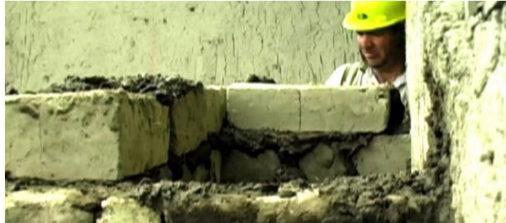
Figura 1. Campaña de mantenimiento de las viviendas de Susudel, proyecto vlrCPM
