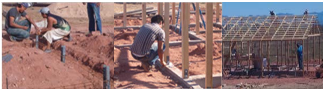
Figura 3a- Desarrollo del proceso constructivo del bajareque mejorado (continúa)
