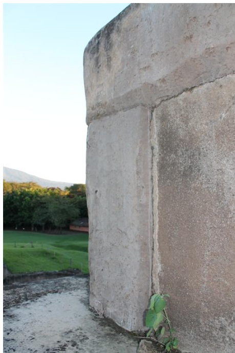
Figura 4. La intervención de la esquina Noreste de la Estructura 1 a un año de su terminación no muestra deterioro alguno a pesar de las adversas condiciones climáticas (Foto L. Guerrero 2014).
