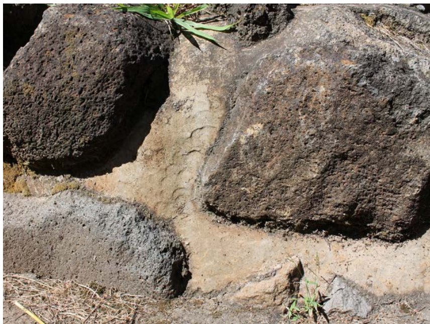
Figura 1. Consolidación del mortero de unión con tierra estabilizada y compactada en Tazumal. Nótese la huella de la herramienta de madera usada para la compactación (Foto L. Guerrero 2014).
