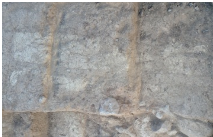
Figura 5. Muro de adobe
