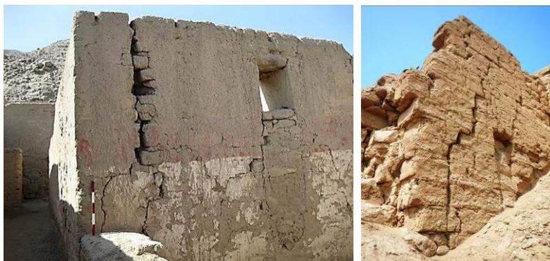
Figura 1. Vista de muros arqueológicos de tierra con agrietamientos que afectan su estabilidad
