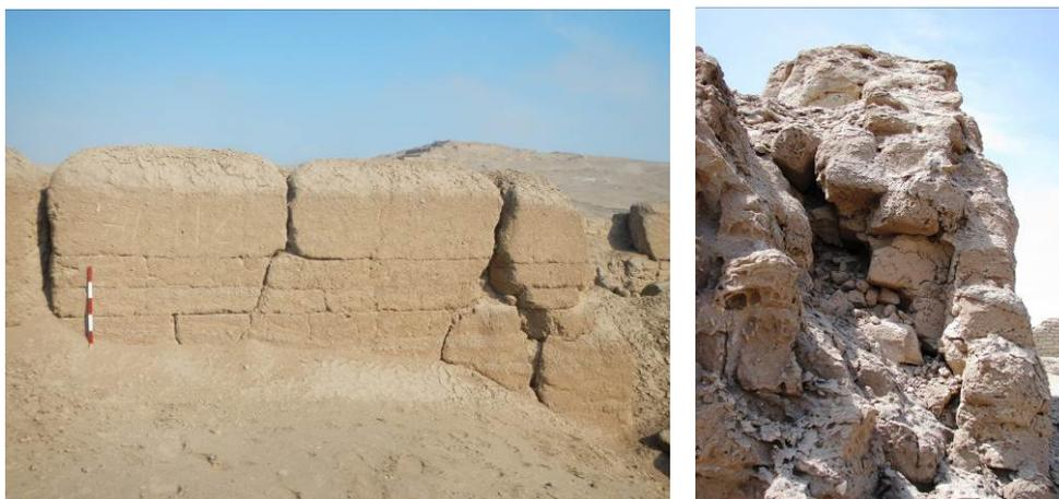
Figura 3 – Agrietamiento de muros. Fuente: Manual de conservación Pachacamac
