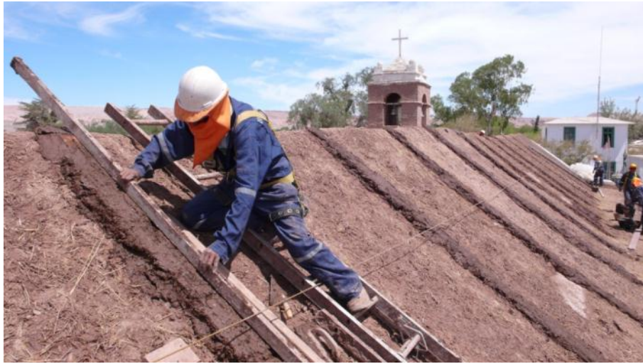
Figura 5. Fabricación de fajas para la aplicación de la segunda capa de 7 cm de espesor. (Fernando Rivera, 2014)
