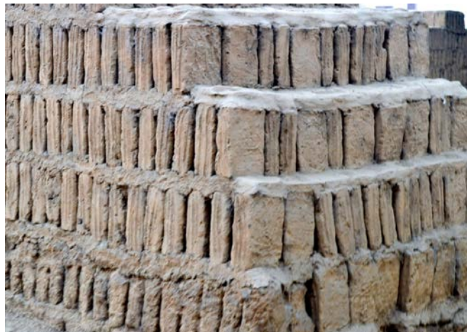
Figura 1. La técnica del librero: adobes colocados verticalmente (Crédito: Agüero, 2014)
