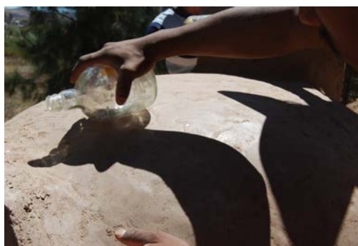
Figura 6. Pulido del enlucido de cal, arena y polvo de ladrillo. (Foto: L. Guerrero, 2015).
