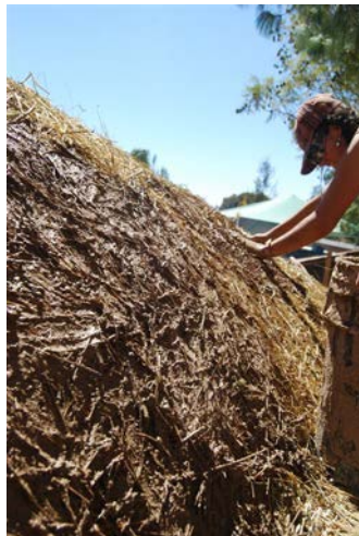
Figura 4. Capas sucesivas y alternadas de paja colocada sobre revoques frescos de tierra arcillosa. (Foto: L. Guerrero, 2013).
