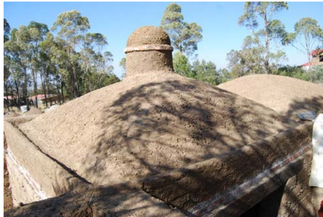
Figura 3. Anillo de refuerzo realizado con carrizos, haces de paja bañada en tierra arcillosa y cob (Foto: L. Guerrero, 2013).
