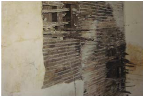
Figura 10. Barrotillo en el interior del caso de estudio 1
