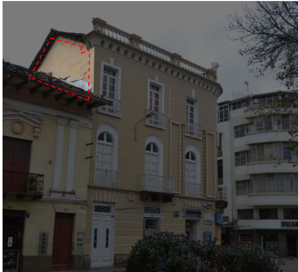
Figura 7. Edificación de bahareque cubierta con tol en la culata
