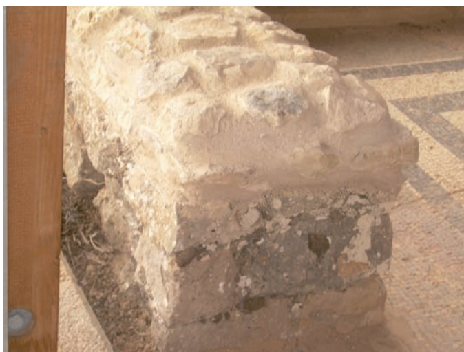
Fig. 2.- "Capa de sacrificio". Clunia. Trabajo de campo.
