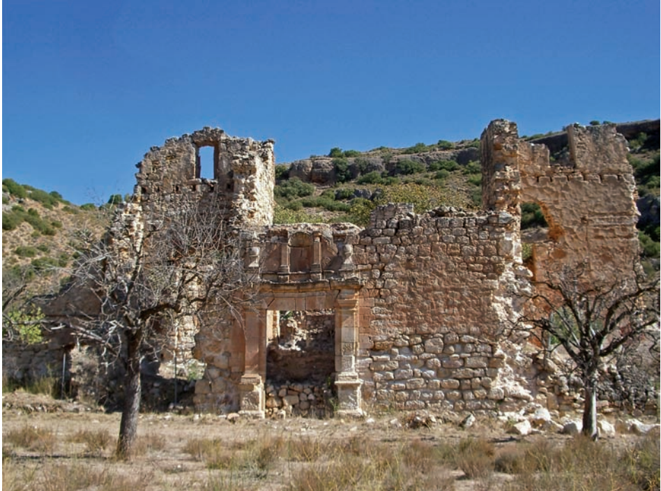
Fig. 1.- Estado actual fachada principal.
